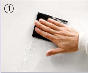
① Limpiar superficie de pared y techo
