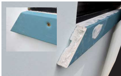
Masillar perforaciones y uniones
