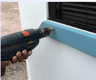
En caso de drywall hacer guía con broca pequeña antes de entornillar
