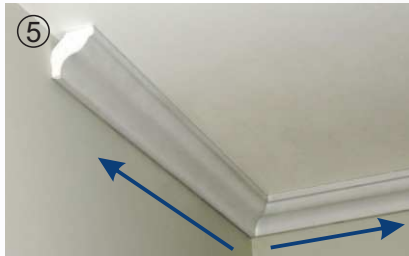
⑤ Comenzar a instalar por las esquinas para facilitar los cortes en la parte central
