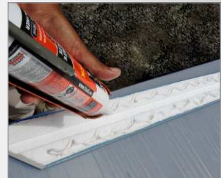
Cortar con Sierra y aplicar pegamento en forma de serpentin
