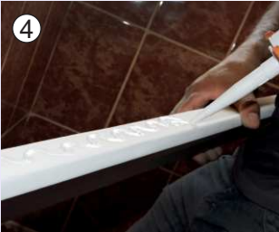
④ Aplicar el pegamento en forma de serpentin
