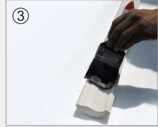
③ Lijar la moldura y aplicar base blanca al agua
