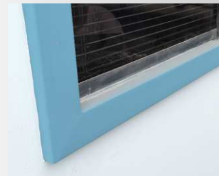
Dejar secar, lijar y dar ultima capa de pintura
